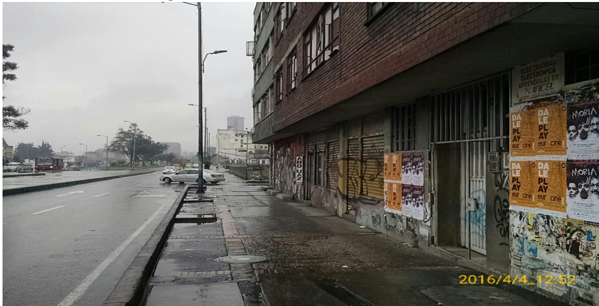
Fotografía 15. Fachada de la Av. Caracas No. 24-06
