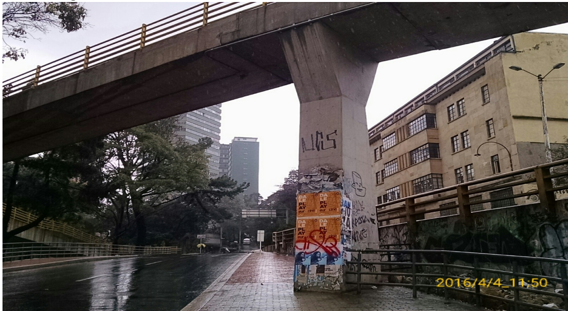
Fotografía 2. Columna Punte de la Calle 26 con Carrera 5 sentido sur – norte
