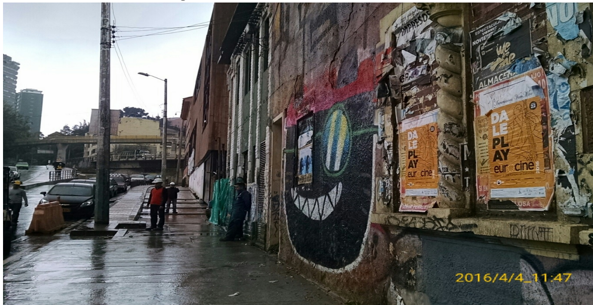
Fotografía 3. Fachada de la Carrera 5 No. 24-04
