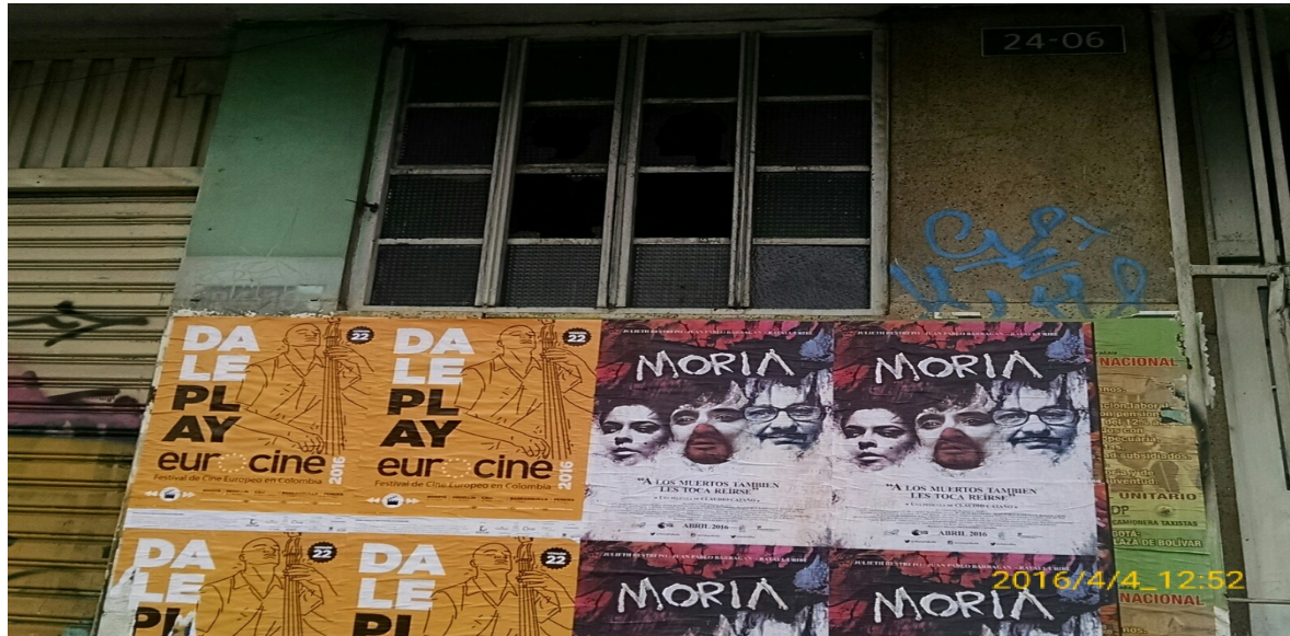
Fotografía 14. Fachada de la Av. Caracas No. 24-06
