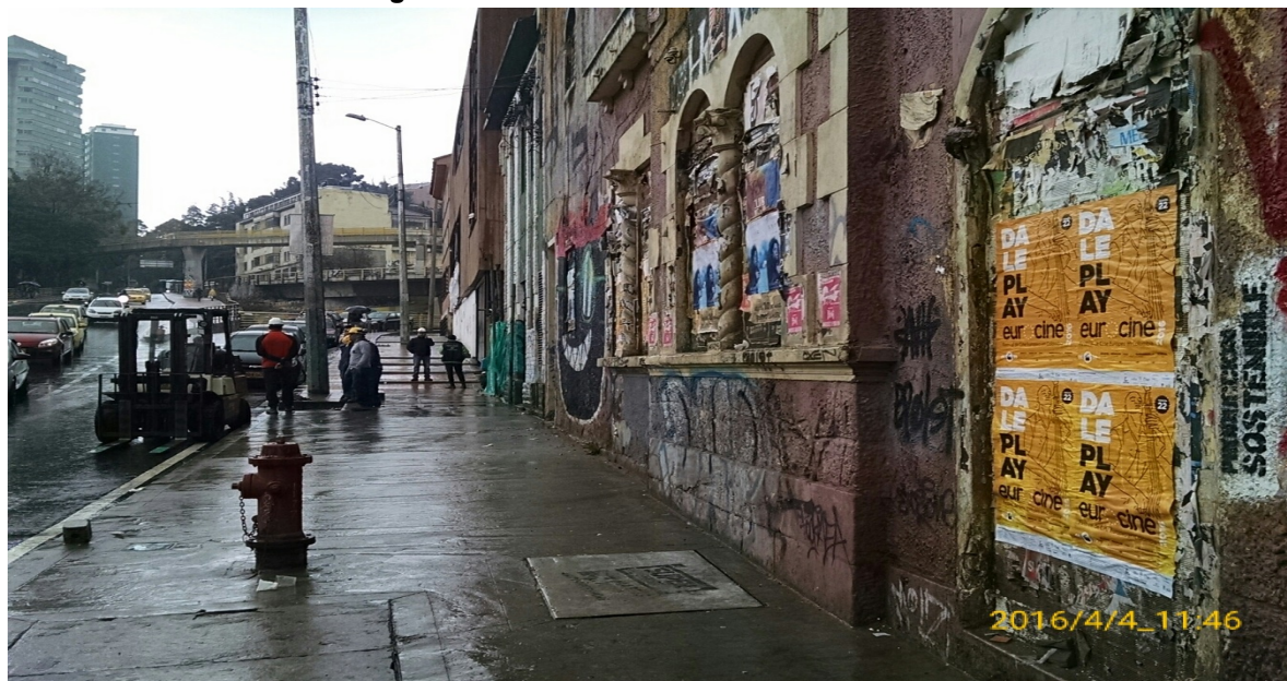
Fotografía 5. Fachada de la Carrera 5 No. 24-04
