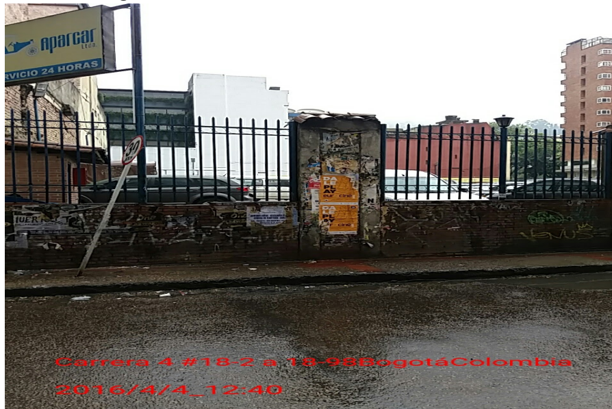
Fotografía 8. Cerramiento de la Calle 19 con Carrera 4
