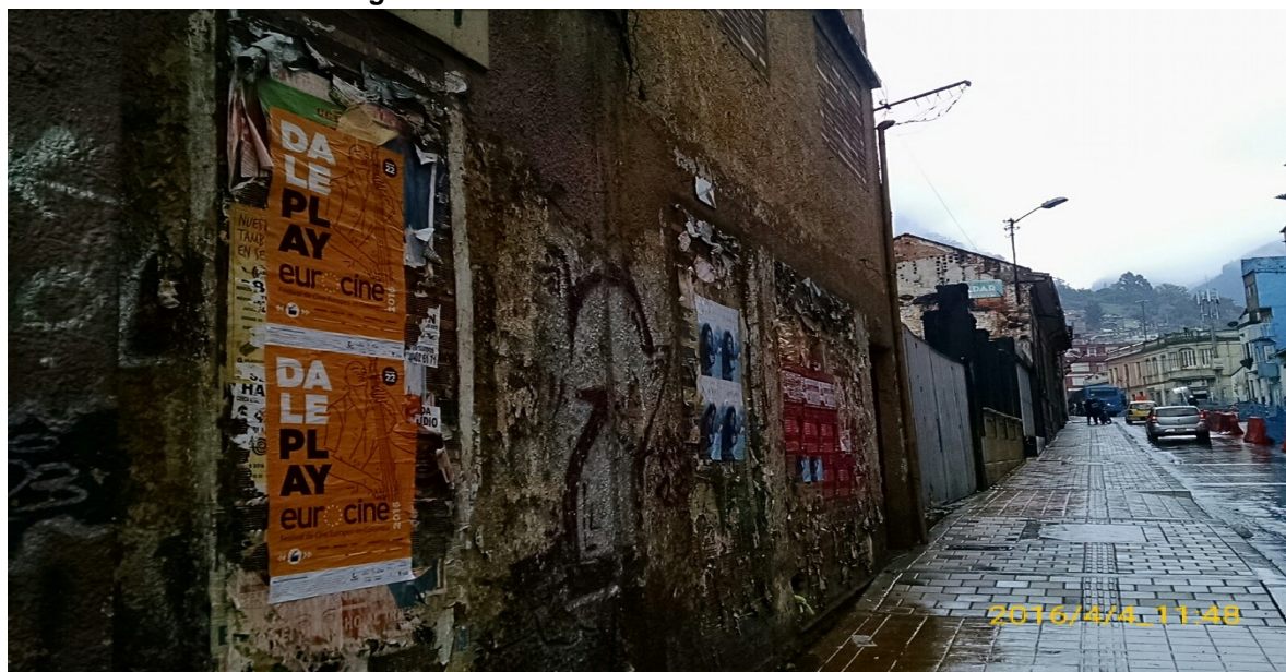
Fotografía 4. Fachada de la Calle 24 con Carrera 5
